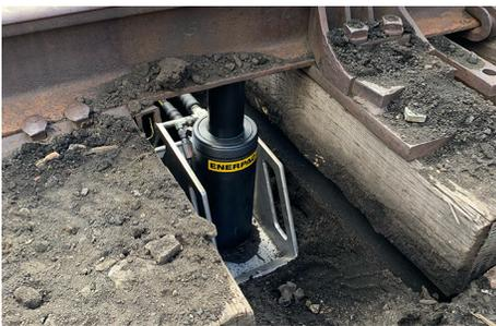
Quatre cylindres de levage encadrés, d'une capacité de 62 tonnes chacun, offrant une capacité de levage totale de 248 tonnes.
